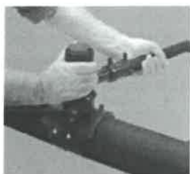
d) Fixarea țevii de bransament
