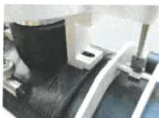
Montajul șeilor de ramificație top-load, până la efectuarea sudurii
